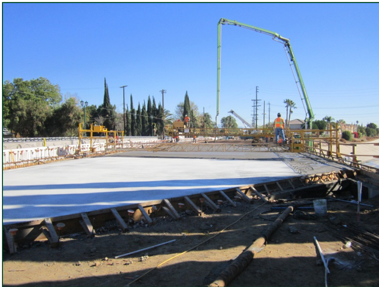
Concrete Pour for South Deck (October 2013)
